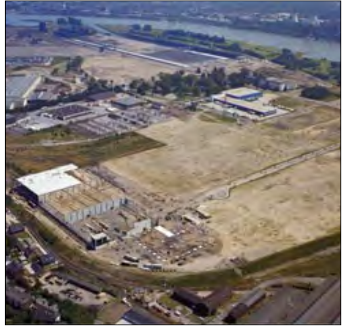
4.1.23 Duisburg: Logport construction site, 2002
